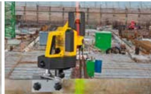
Перенос осей с обноски на фундаментную плиту. Одним нажатием кнопки вертикальная лазерная линия автоматически центрируется в диапазоне до 40 м.
