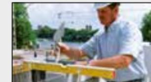
Тип 96-2 K: запатентованная антидetonационная система. Коррекция отклонений выполняется непосредственно путем легких ударов кельмой.
